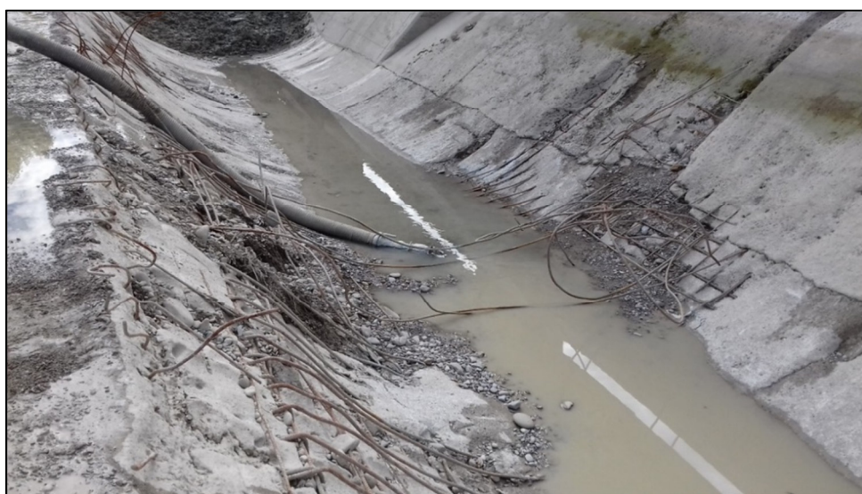
Figura 4-2 – Manufatto Limitatore di Monte-Armature del fondo vasca scalzate
