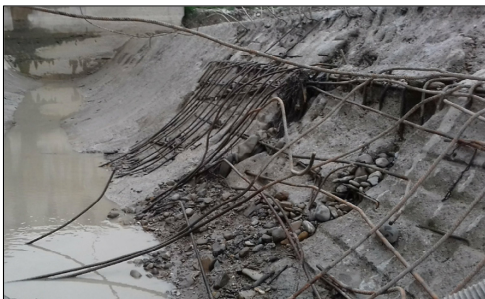
Figura 4-1 – Manufatto Limitatore di Monte-Armature scalzate del bordo vasca
