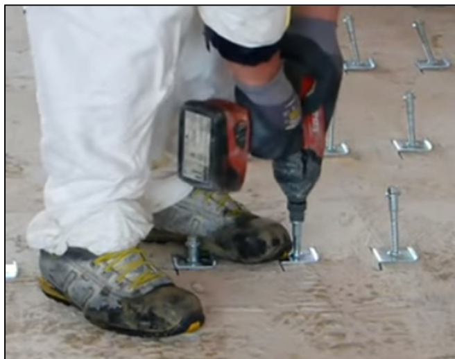
Figura 6-3 – Applicazione connettori meccanici.
