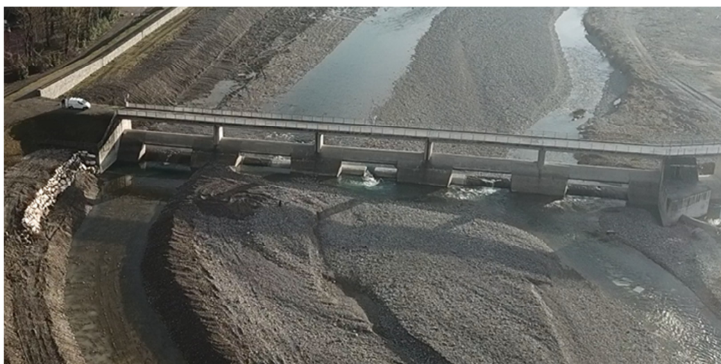
Figura 1-1 – Manufatto Limitatore di Monte- Tratta in alveo
