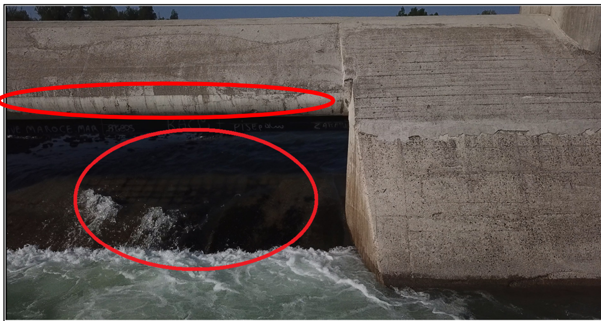
Figura 5-1 – Abrasione superficiale della vasca e segni di degrado sulla trave laminatrice.
